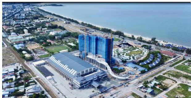
【建築中のベトナムダナンプロジェクト全景】
