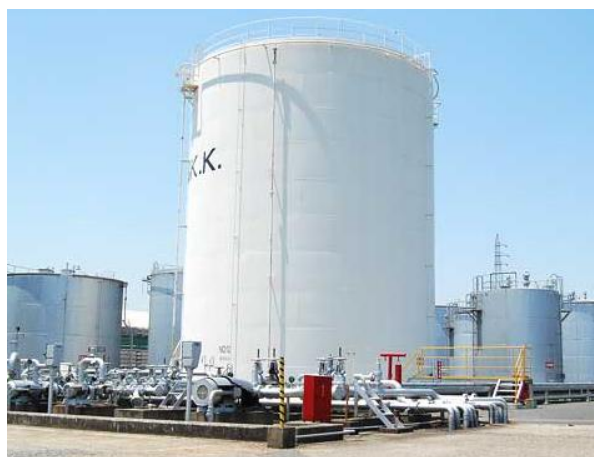
【同社備蓄基地内の油槽タンク】
