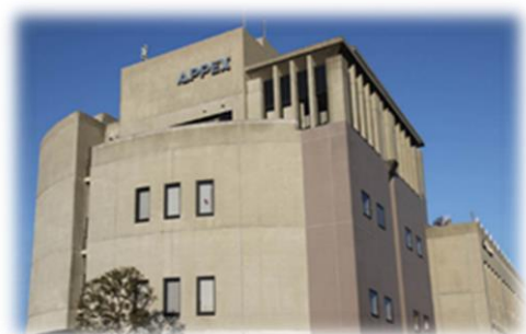
【市川プロダクションセンター】
