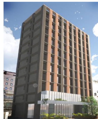
【新築リニューアル後の外観イメージ】
