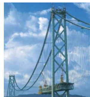
【同社塗装工事施工例】
