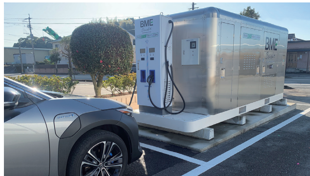
移動式急速充電機「BME Benefit」は、電気自動車に最大90kwで急速充電が可能
