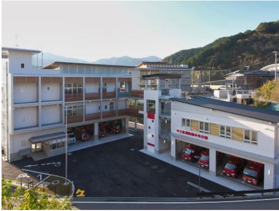
写真4 高幡消防組合中土佐分署建設工事
