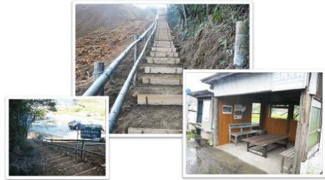
写真33 再生材を使用した山道・ベンチ （出典：ミタニ建設工業ウェブサイトより）
