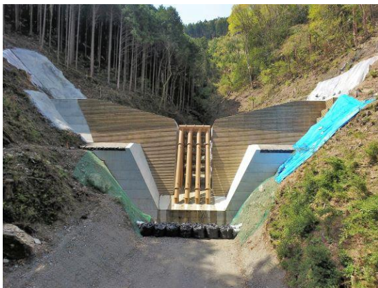
写真6 屋所谷右支堰堤工事
