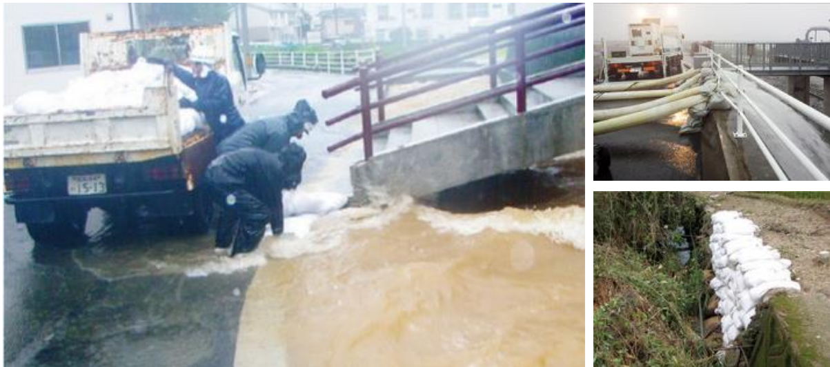
写真12 ミタニ建設工業が行った復旧作業の様子（出典：ミタニ建設工業ウェブサイトより）
